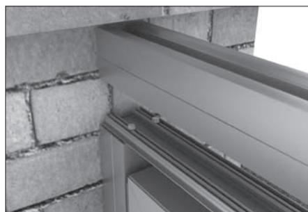
Сверху на профиль «крышка столба» установите профиль «корпус столба». Защелкните профиль.
