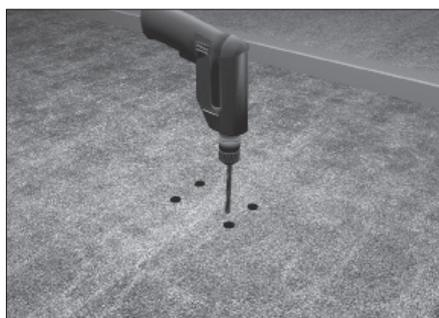
Просверлите 4 отверстия  $\varnothing 13$  в дорожном покрытии.
