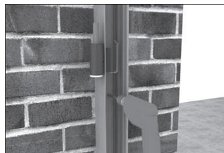
Просверлите сверлом 4 мм алюминиевый профиль «корпус столба» по всей высоте, с шагом не более 500 мм.
